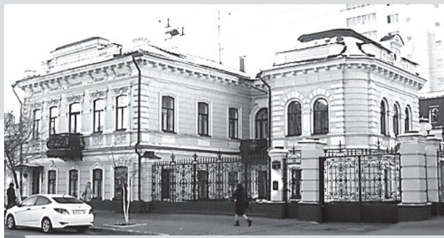
Здание по улице Московской, 99.
