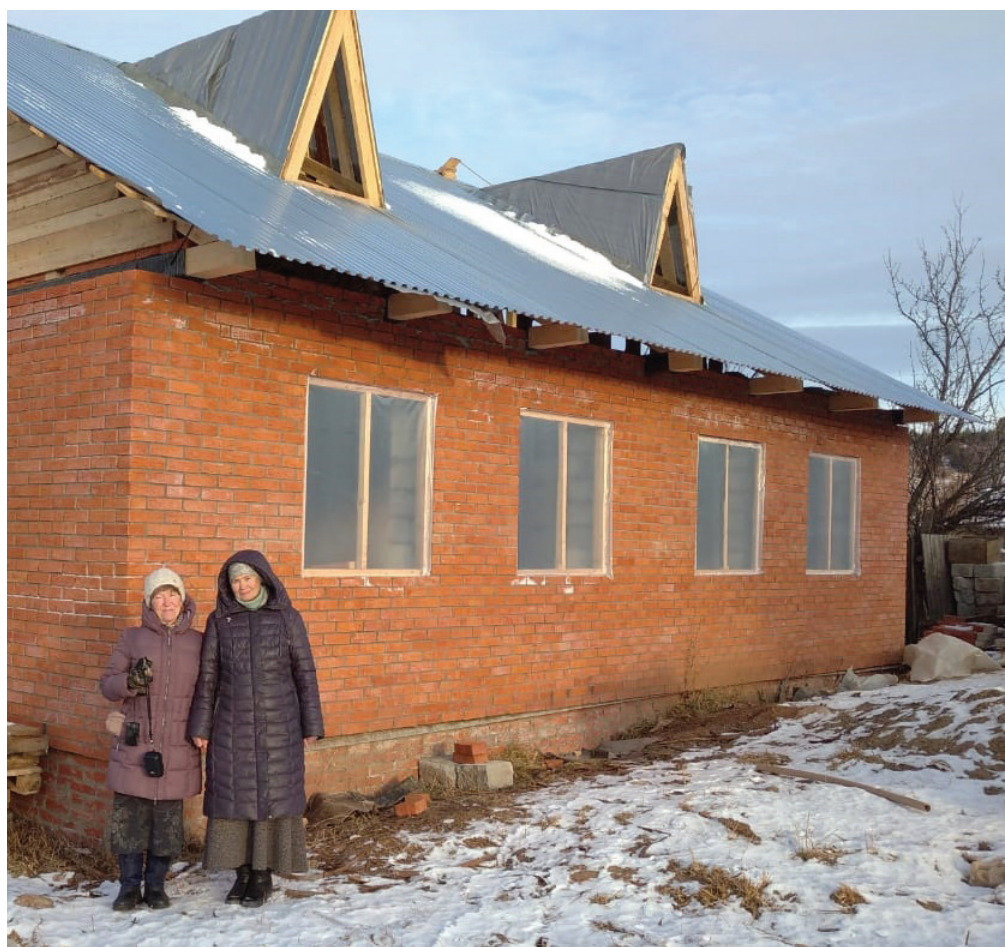
Строящаяся Кельчинская школа здоровья и трезвения
